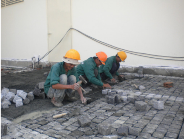
Verlegeteam von Stone Hill bei Danang. Workers of Stone Hill near Danang.
