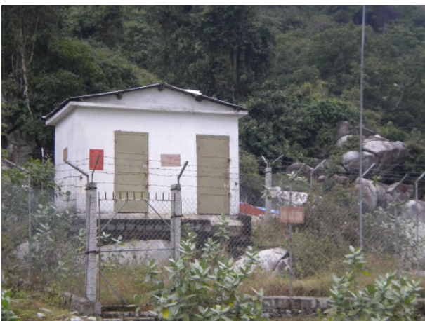
Verschlussener, eingezäunter Dynamitschuppen. Locked and fenced shelter of dynamite.
